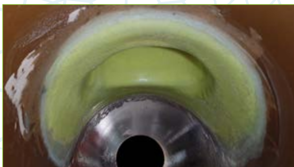
Resultaat van het SAERTEX® multiHat combi-systeem.
