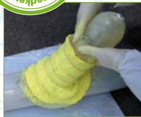
Fixeren en in positie zetten van de UV - Packer
