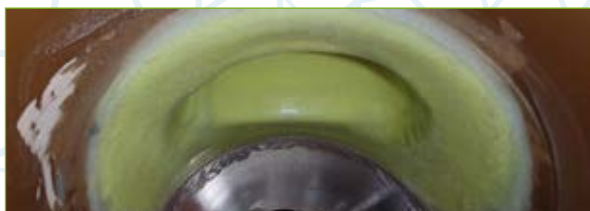
SAERTEX® multiHat combi - Résultat après installation
