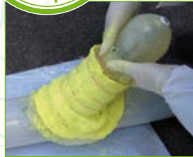
Belegung des UV-Packers
