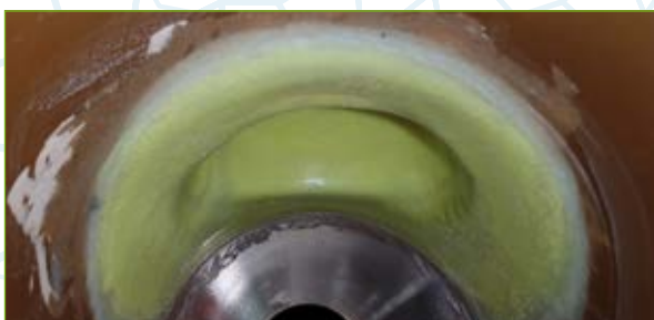
SAERTEX® multiHat combi Einbauergebnis
